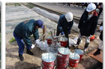
防災協力井戸の設置
